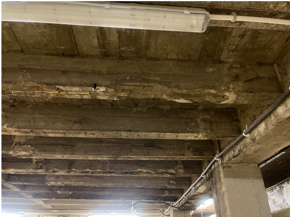
Strop nad piwnicami – fragment stropu żebrowego, ubytki otuliny żeber
