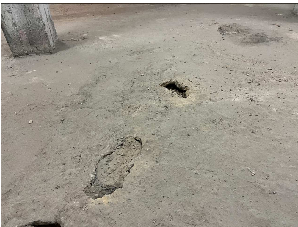
Deformacja podłogi na gruncie
