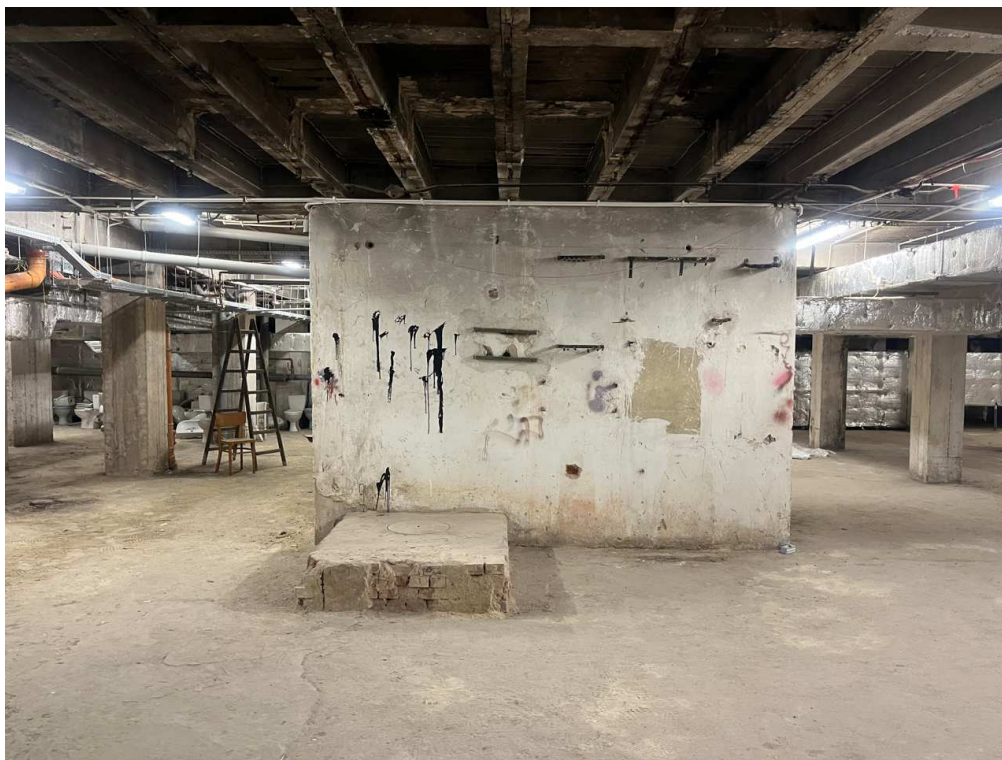
Widok stropu żebrowego oraz ściany klatki schodowej zachodniej
