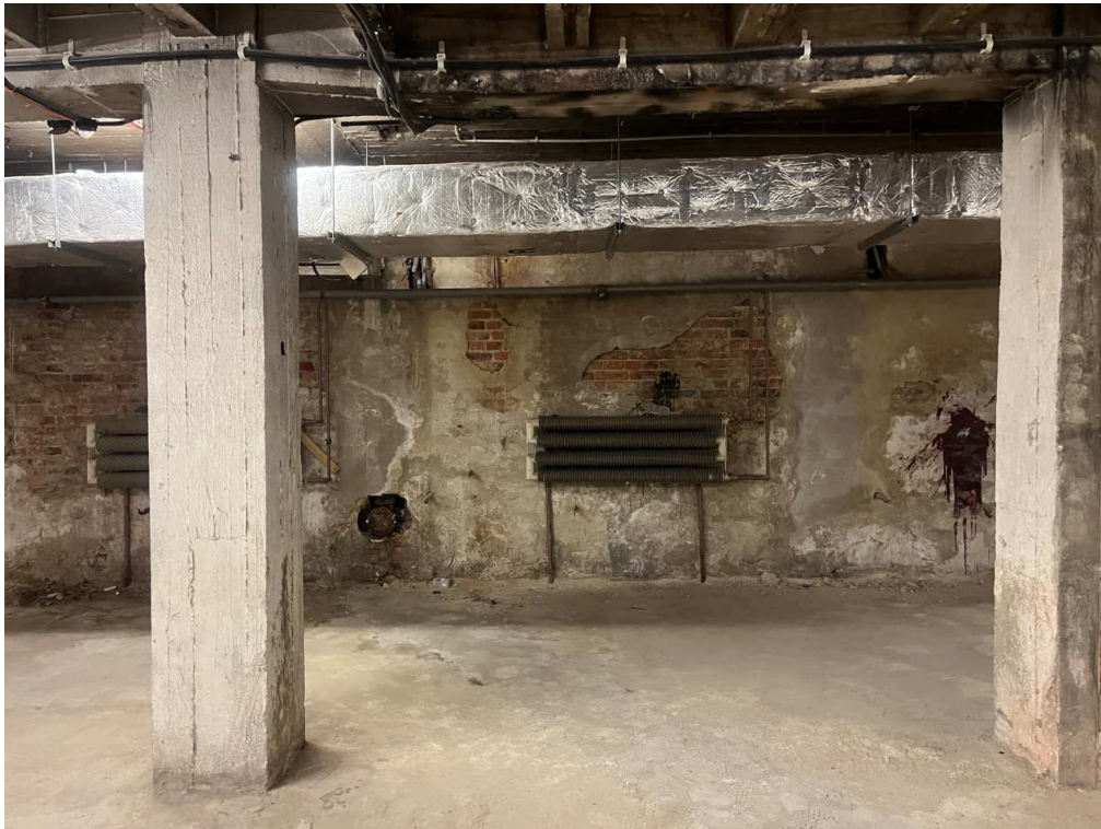
Konstrukcja żelbetowa stropu nad piwnicami – widoczne odkształcenia belek po deformacji szalunków
