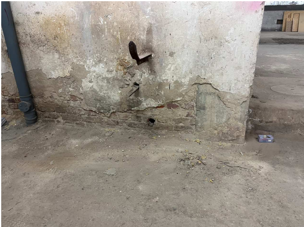
Ściana klatki schodowej zachodniej – widok konstrukcji budynku oraz wypełnienia murowanego między słupami
