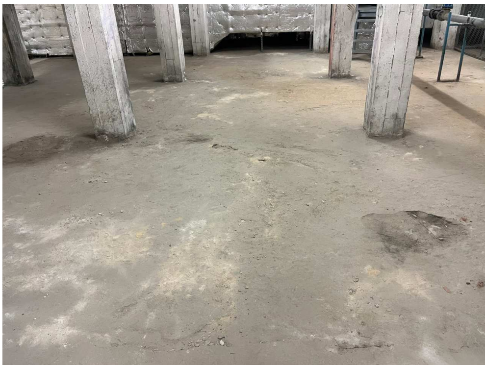
Deformacja podłogi na gruncie
