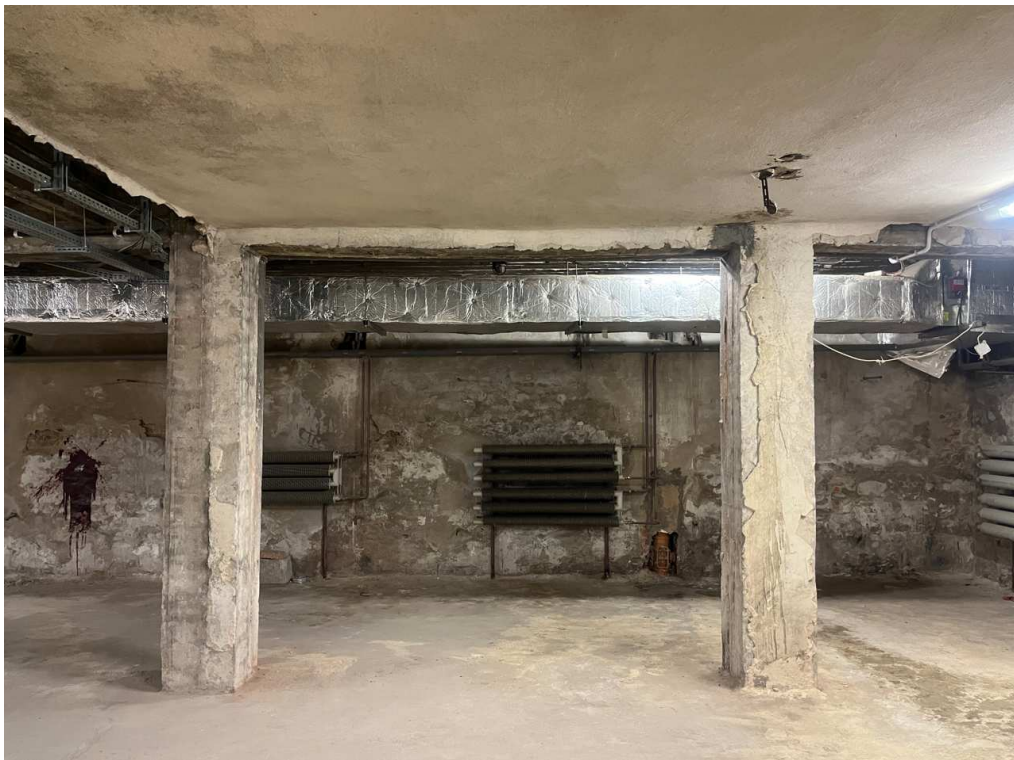
Strop nad piwnicami – fragment stropu żebrowego osłonięty okładziną
