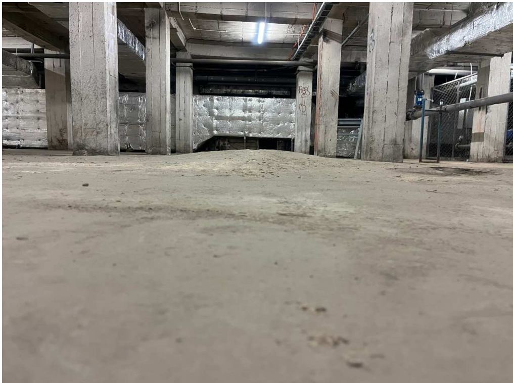
Deformacja podłogi na gruncie – widok z poziomu podłogi
