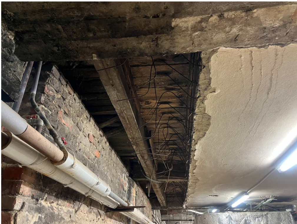
Strop nad piwnicami – fragment stropu żebrowego osłonięty okładziną – przerwanie okładziny
