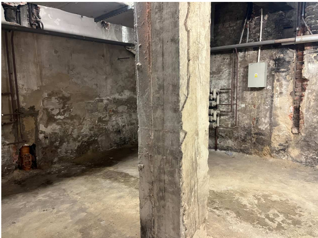
Ubytki tynku na słupach konstrukcji budynku
